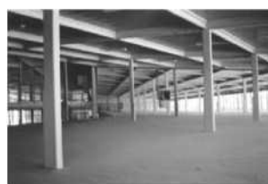
Металлоконструкции окрашены составом МПВО
